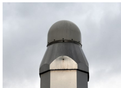
図2 てっぺんの丸いカバーの中にGPSアンテナがあります。
